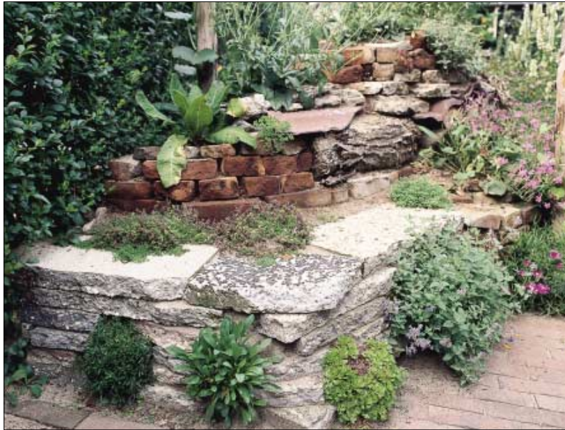
De gestapelde muren is een verzameling van diverse typen stenen zoals oude grindtegels en gebakken stenen. In de gemaakte gaten is beplanting aangebracht.
